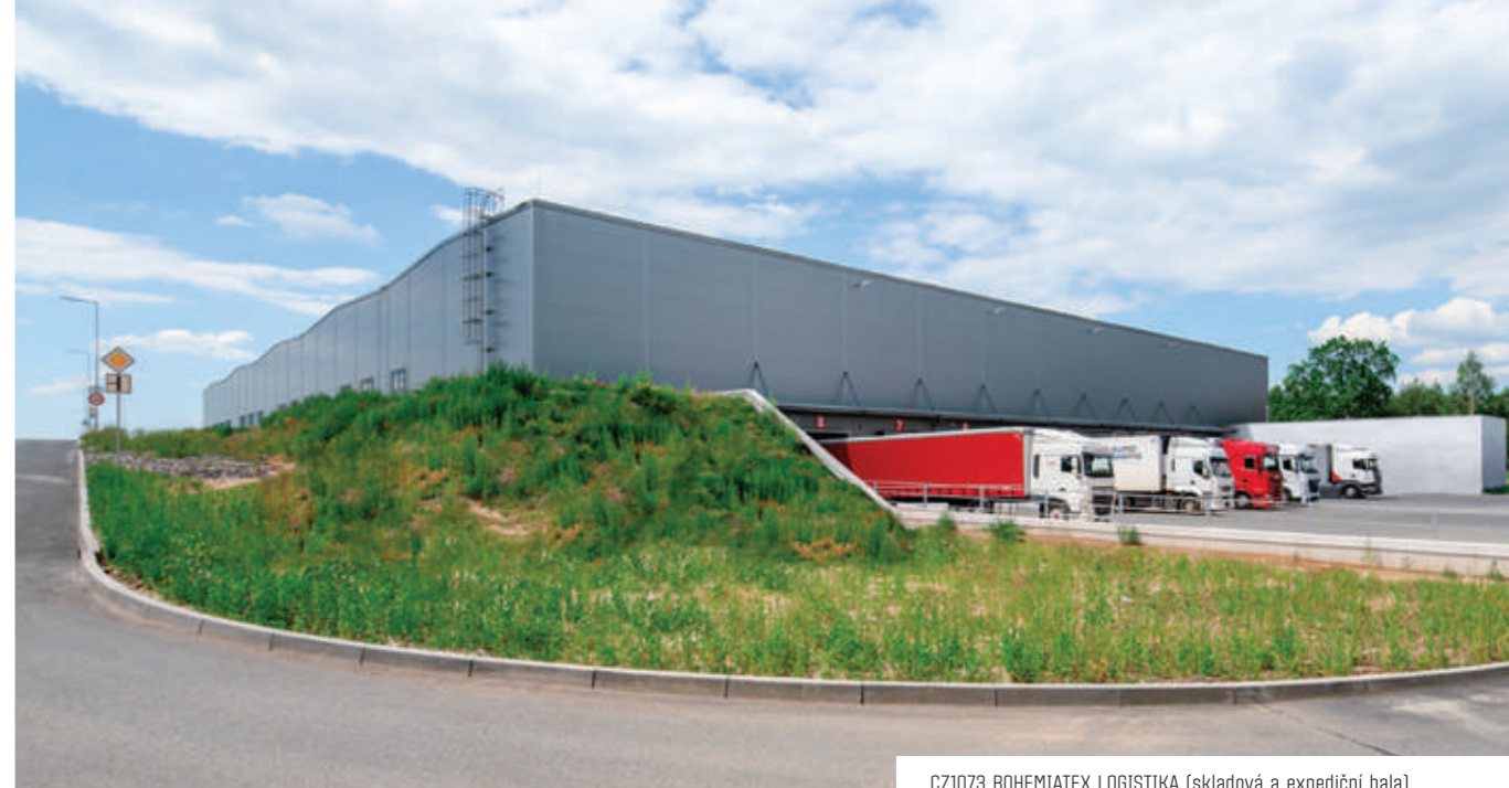
CZ1073 BOHEMIATEX LOGISTIKA (skladová a expediční hala)
